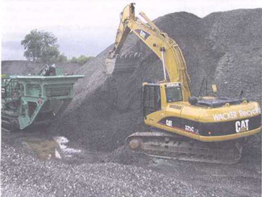
Stehen einander zur Seite beim Aufbereiten von Baustoffen: der Cat-Kettenbagger 325 C sowie die Prallbrecheranlage Giporec R131 FDR GIGA. Foto: Wacker
